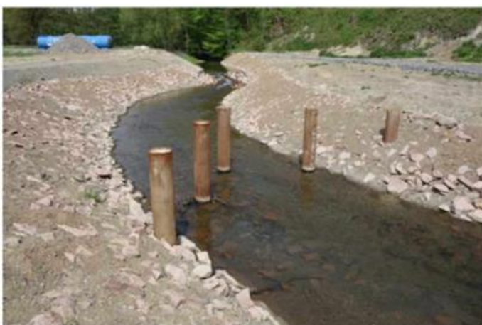
Abbildung 8: V-Rechen im Bereich des HRB Wippra (Eiden 2016).
