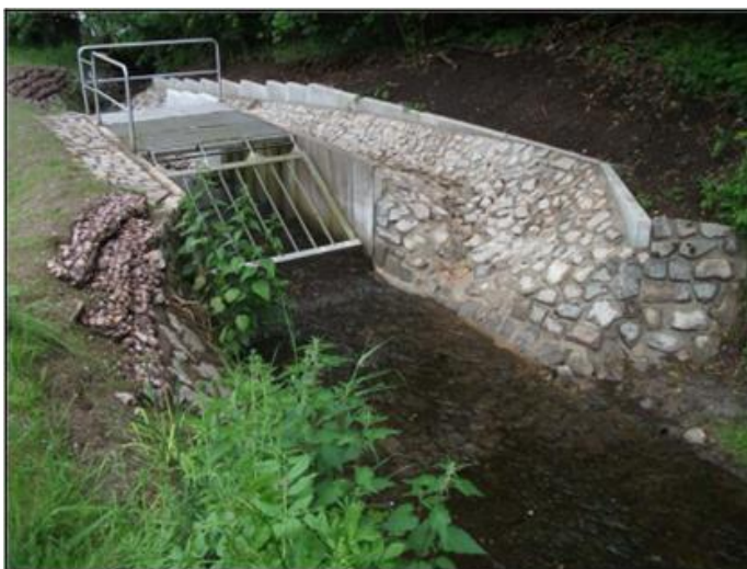
Abbildung 7: Treibgut-/Geschiebefang mit seitlicher Überlaufstrecke (Landeshauptstadt Dresden Umweltamt, 2016).
