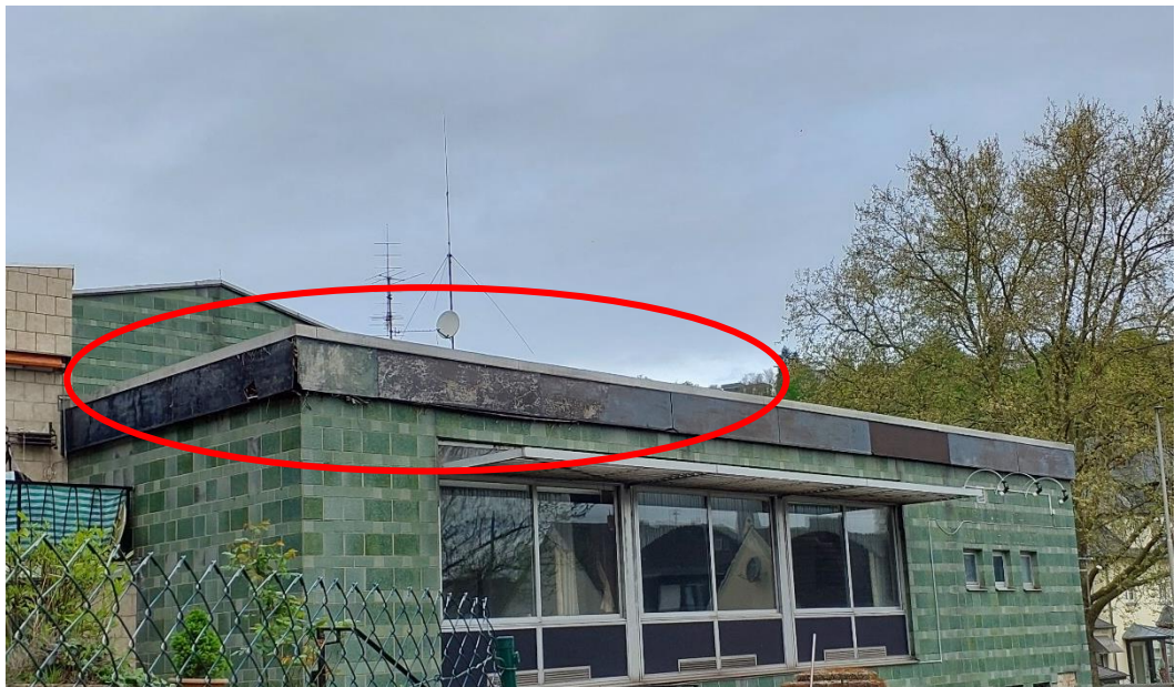
Abb. 3: Potenzielle Sommerquartiere für Fledermäuse an alter Stadthalle
